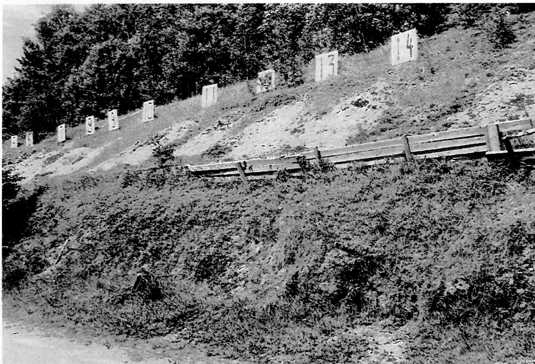
Figur 7.4 Skytebane på Hauerseier. Kulefangervoll bygd opp av sand over naturlig terrengnivå.
