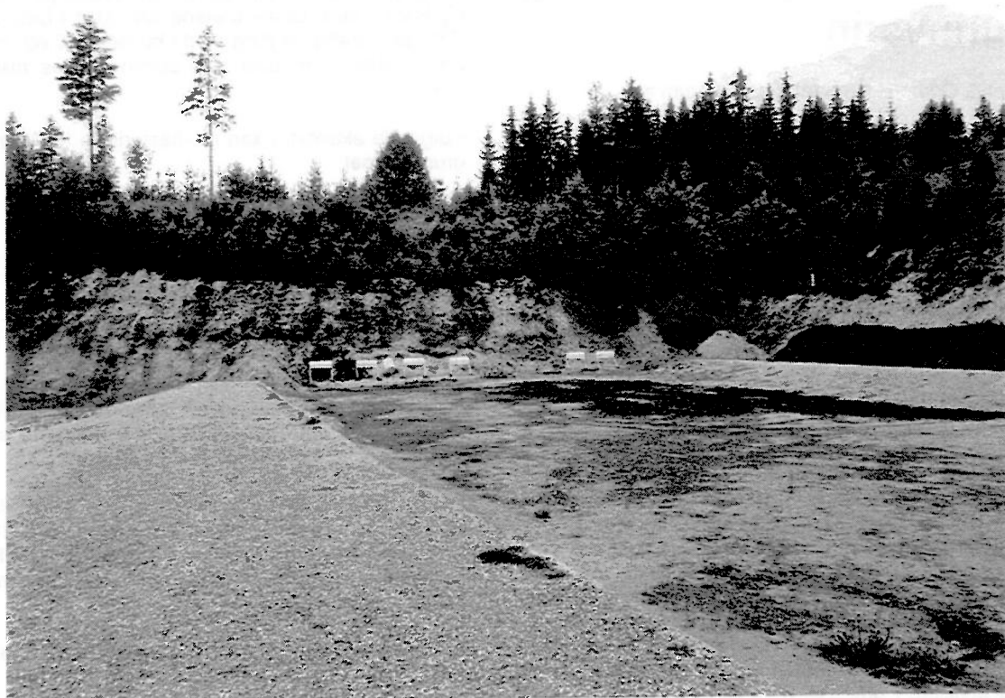
Figur 7.1 Skytebane på Sessvollmoen. Kulefangervoll i stedege løsmasser under opprinnelig terreng.
