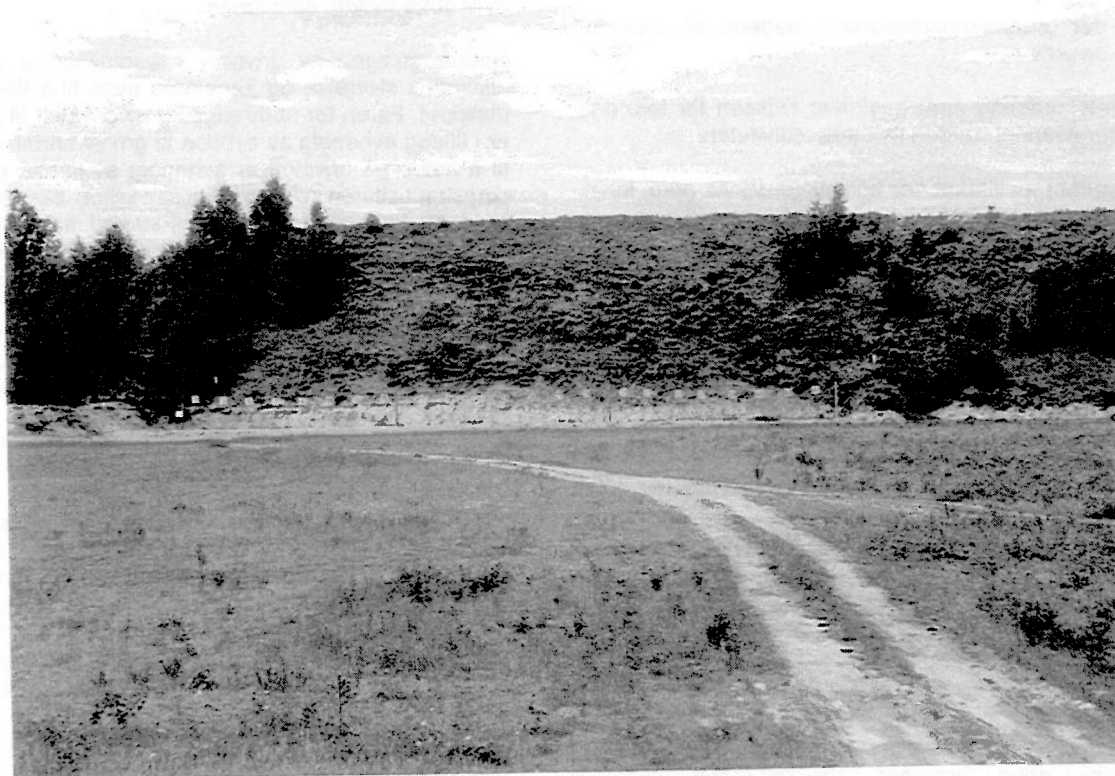
Figur 7.2 Skytebane på Sessvollmoen med kulefangervoll bygd opp over naturlig terrengnivå.
